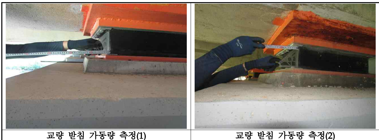
【사진 3.15】 교량받침 이동량 측정
