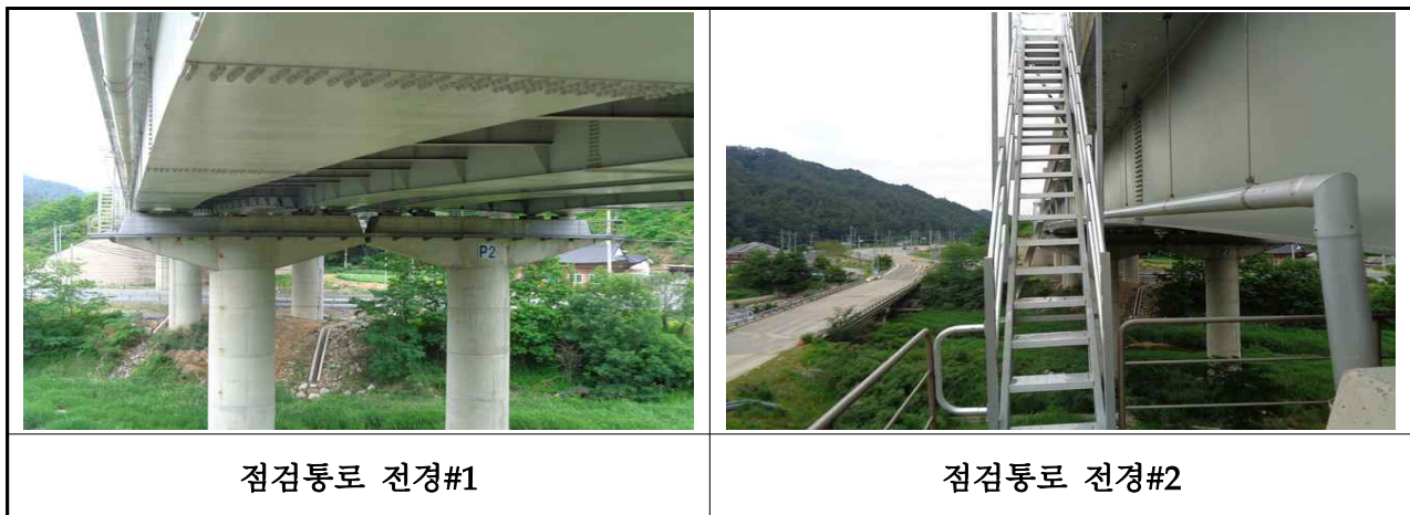
【사진 3.50】 교량 점검시설 전경
