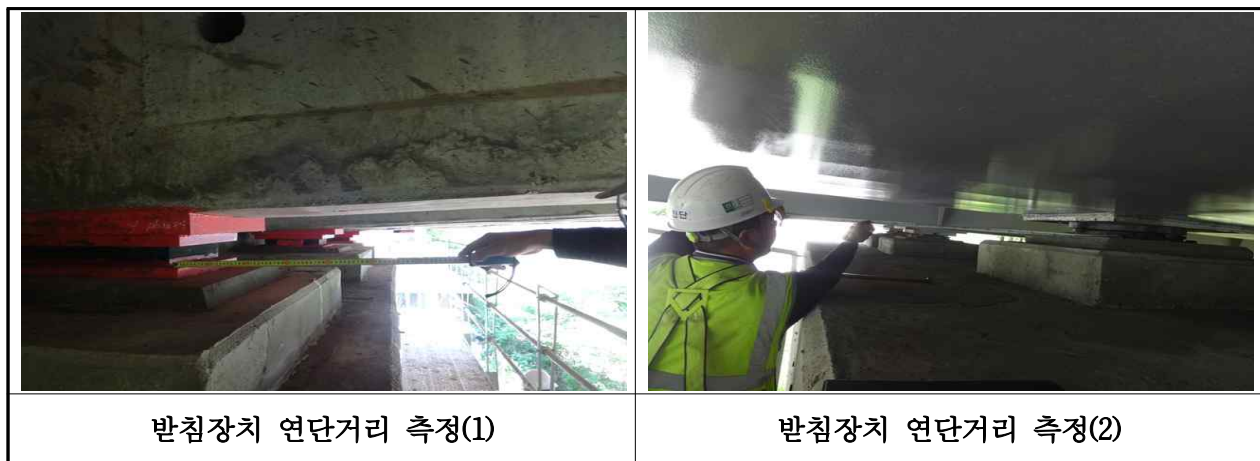
【사진 3.39】 교량받침장치 연단거리측정
