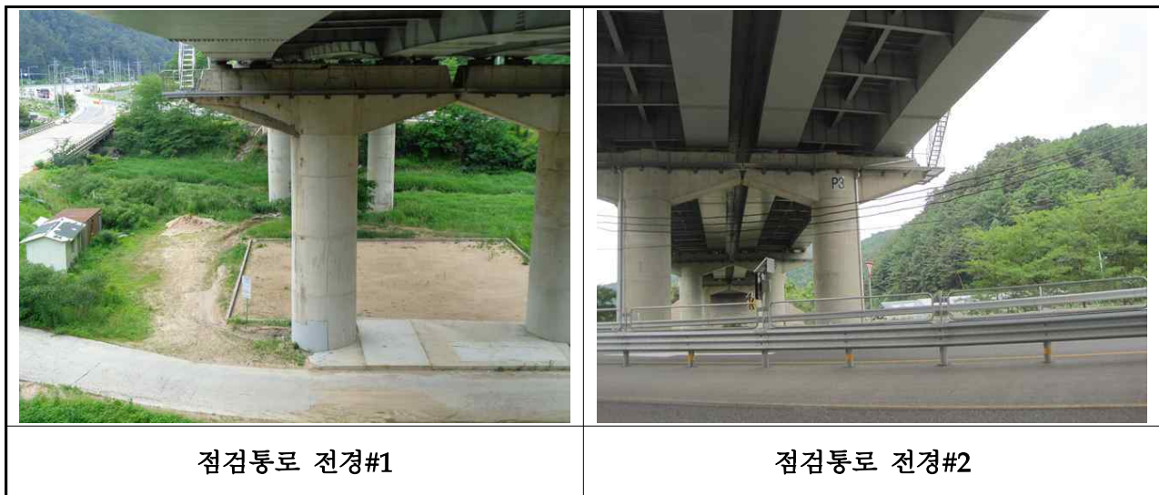
【사진 3.25】 교량 점검시설 전경
