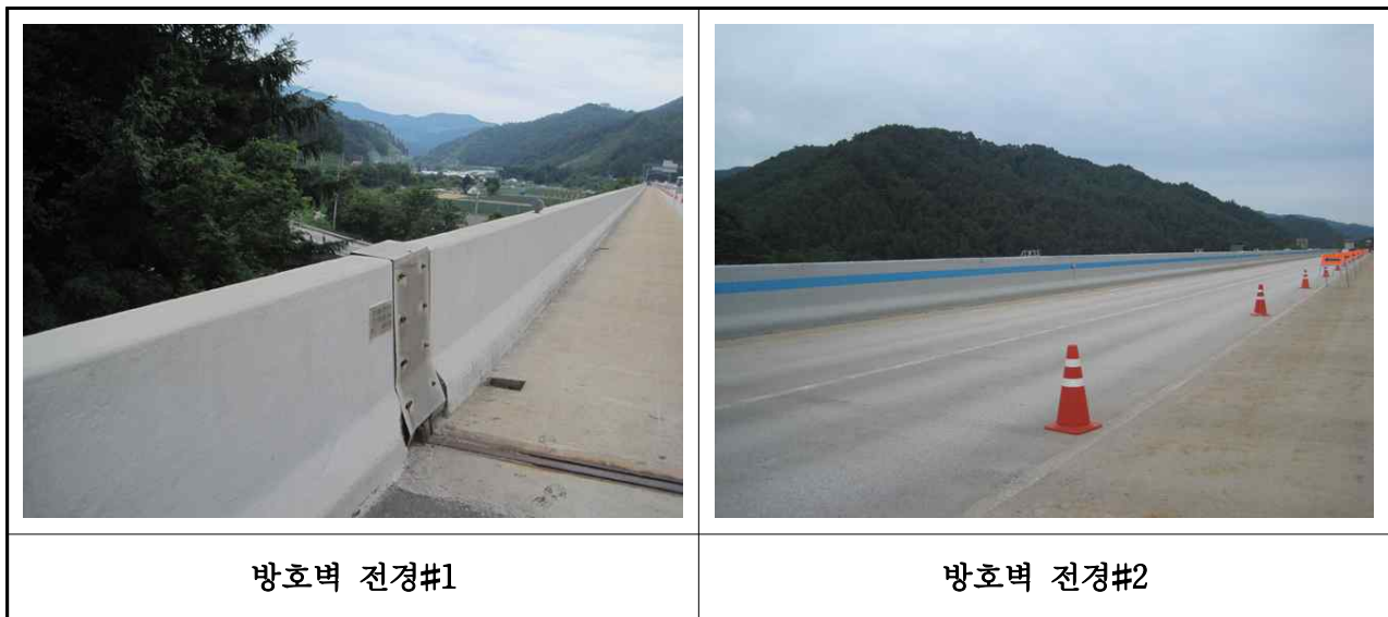
【사진 3.48】 방호벽 및 중앙분리대 전경
