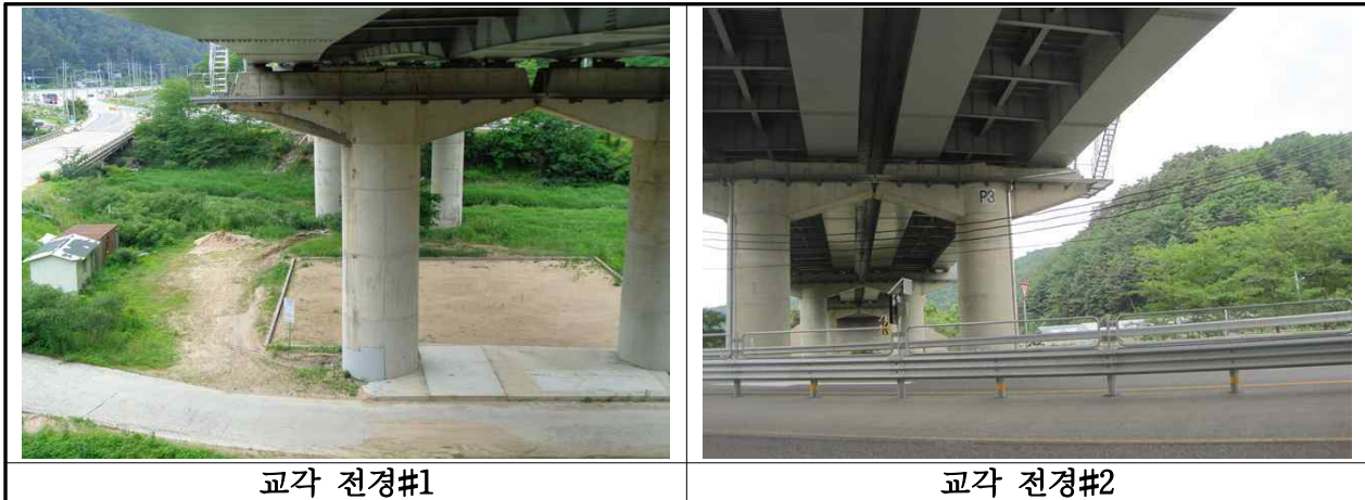
【사진 3.10】 교각 전경
