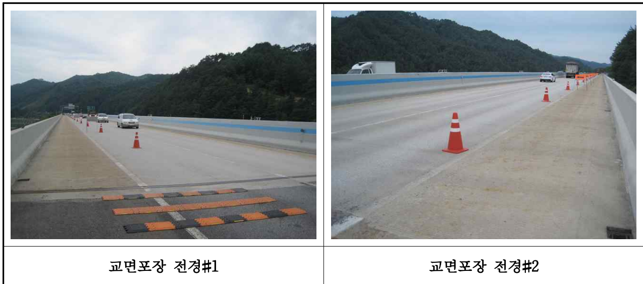
【사진 3.44】 교면포장 전경
