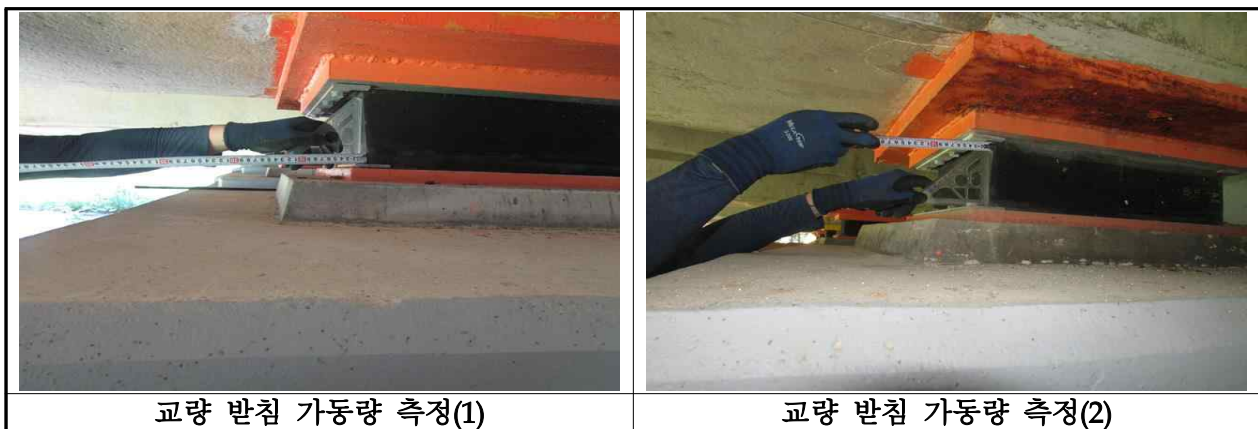
【사진 3.40】 교량받침 이동량 측정
