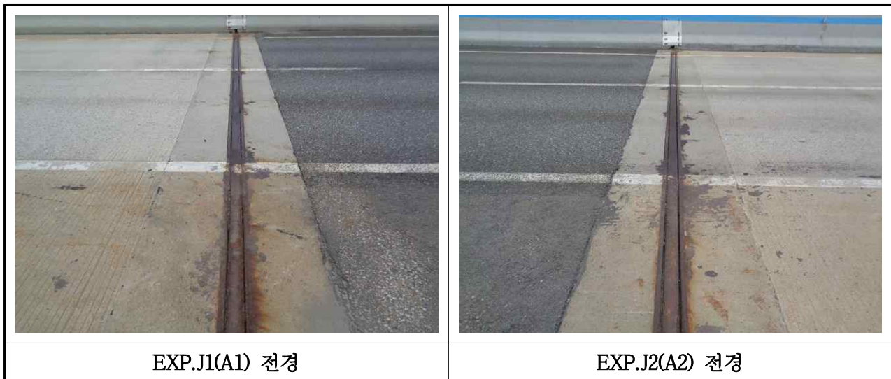
【사진 3.16】 신축이음장치 전경
