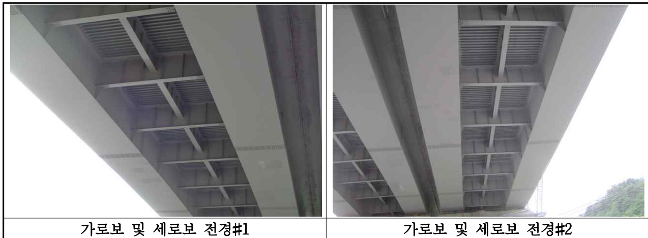
【사진 3.32】 가로보 및 세로보 전경
