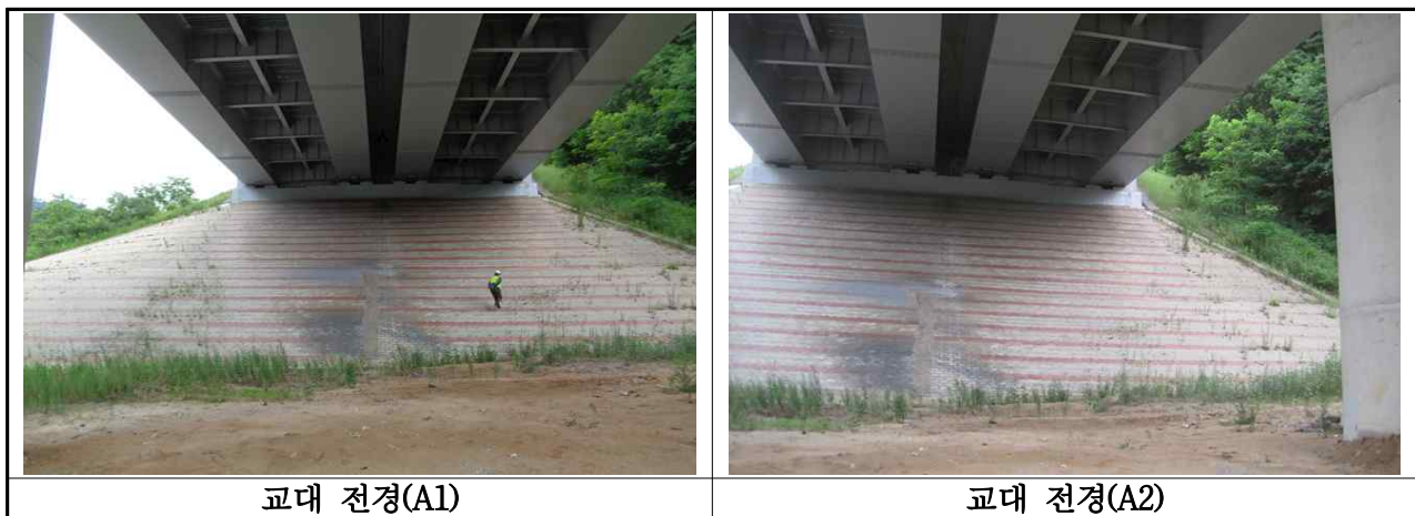
【사진 3.33】 교대 전경
