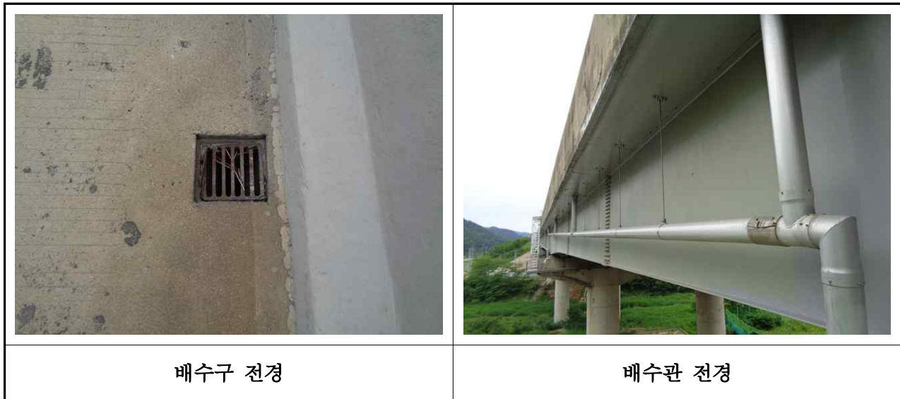
【사진 3.21】 배수시설 전경
