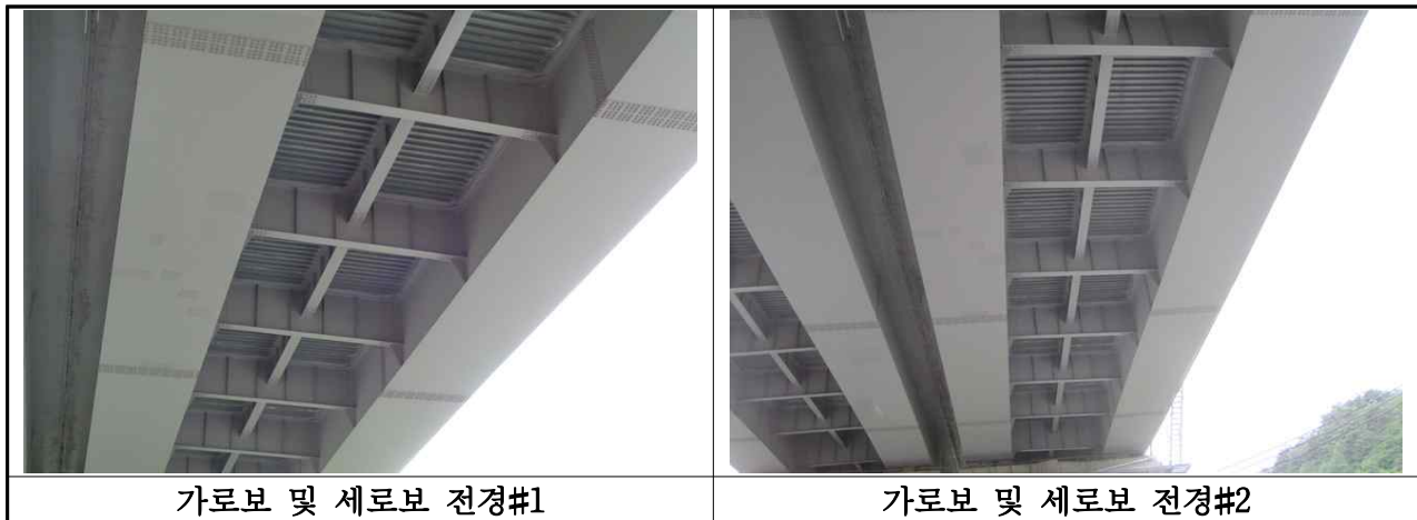
【사진 3.7】 가로보 및 세로보 전경
