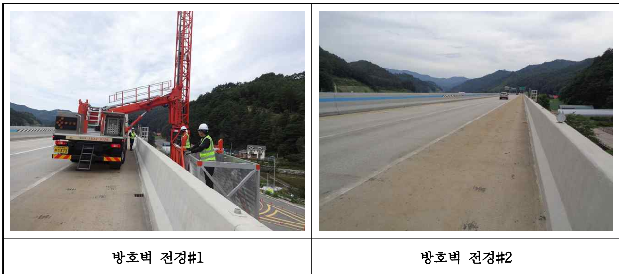
【사진 3.23】 방호벽 및 중앙분리대 전경
