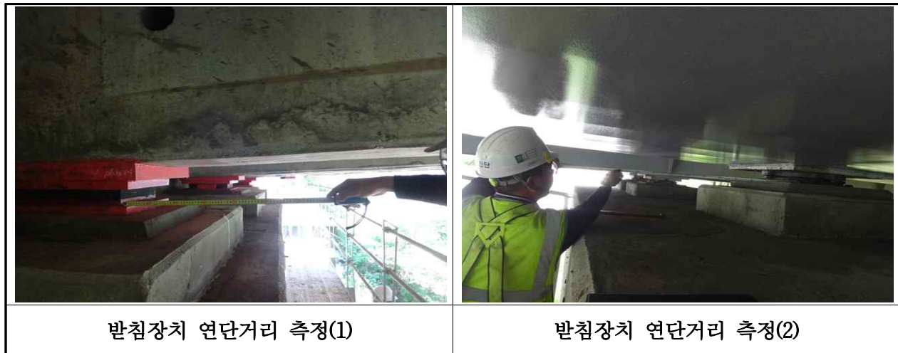
【사진 3.14】교량받침장치 연단거리측정
