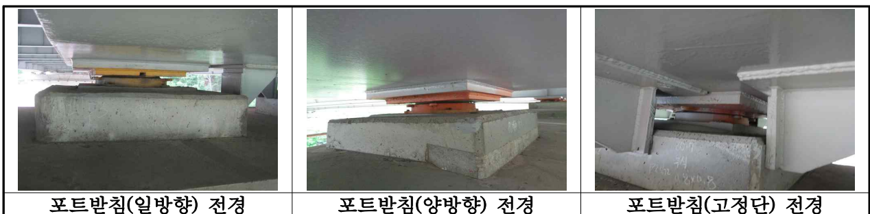
【사진 3.12】 교량받침 전경
