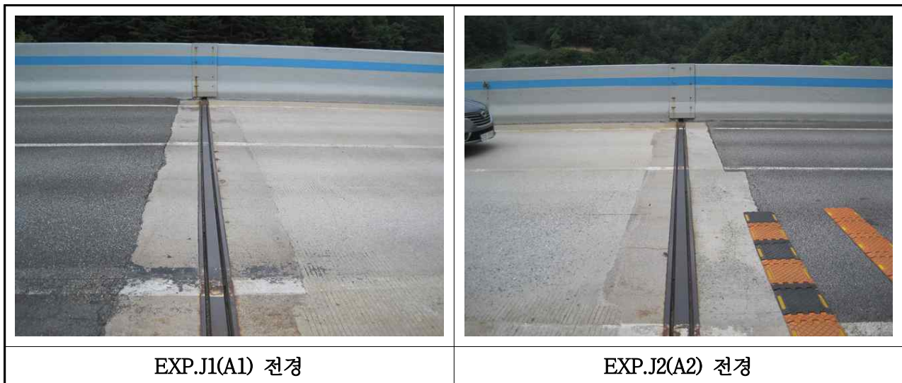
【사진 3.41】 신축이음장치 전경
