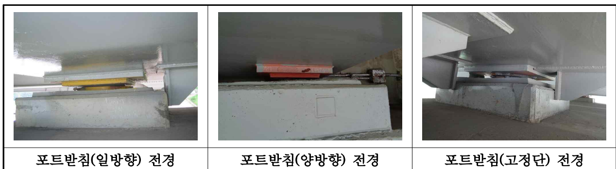
【사진 3.37】 교량받침 전경
