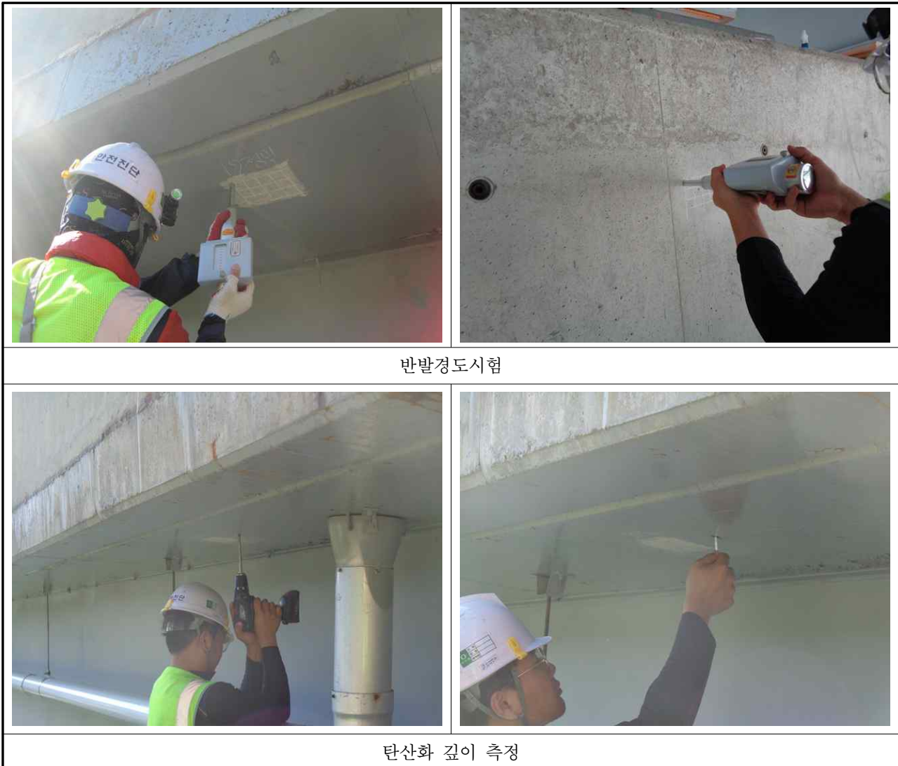
【사진 3.52】 콘크리트 내구성조사 현황
