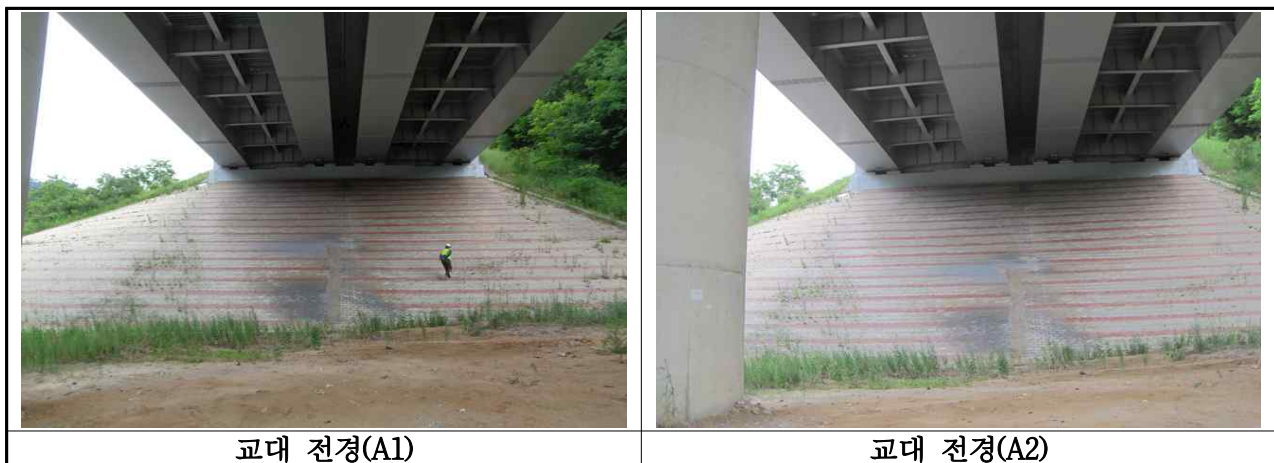
【사진 3.8】 교대 전경
