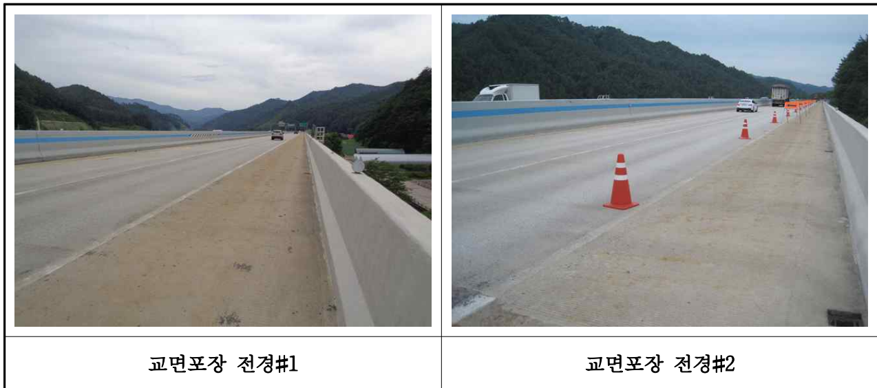
【사진 3.19】 교면포장 전경
