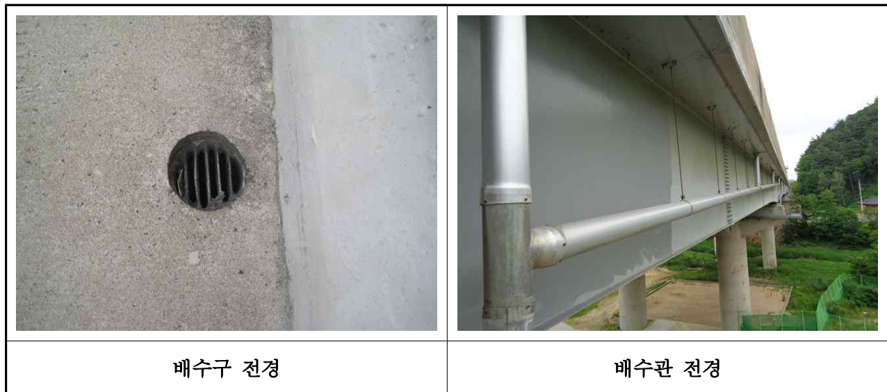
【사진 3.46】 배수시설 전경
